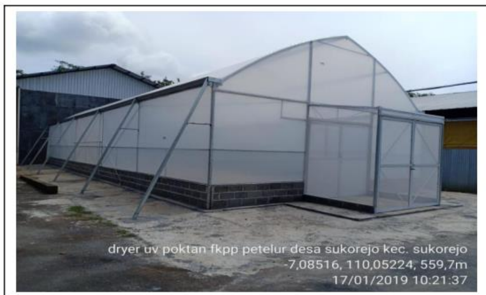
Gambar 2. Contoh Bangunan Dryer UV
